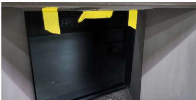
Figure 20.b Maintenez-le en place à l'aide de ruban de masquage
