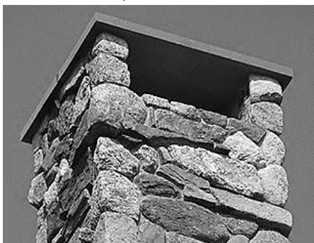
Stone Cap Chimney Top
