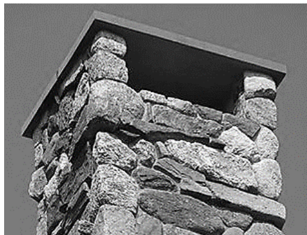
Stone Cap Chimney Top
